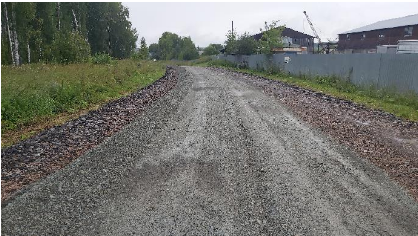
Устройство покрытия из ЦПС С1
