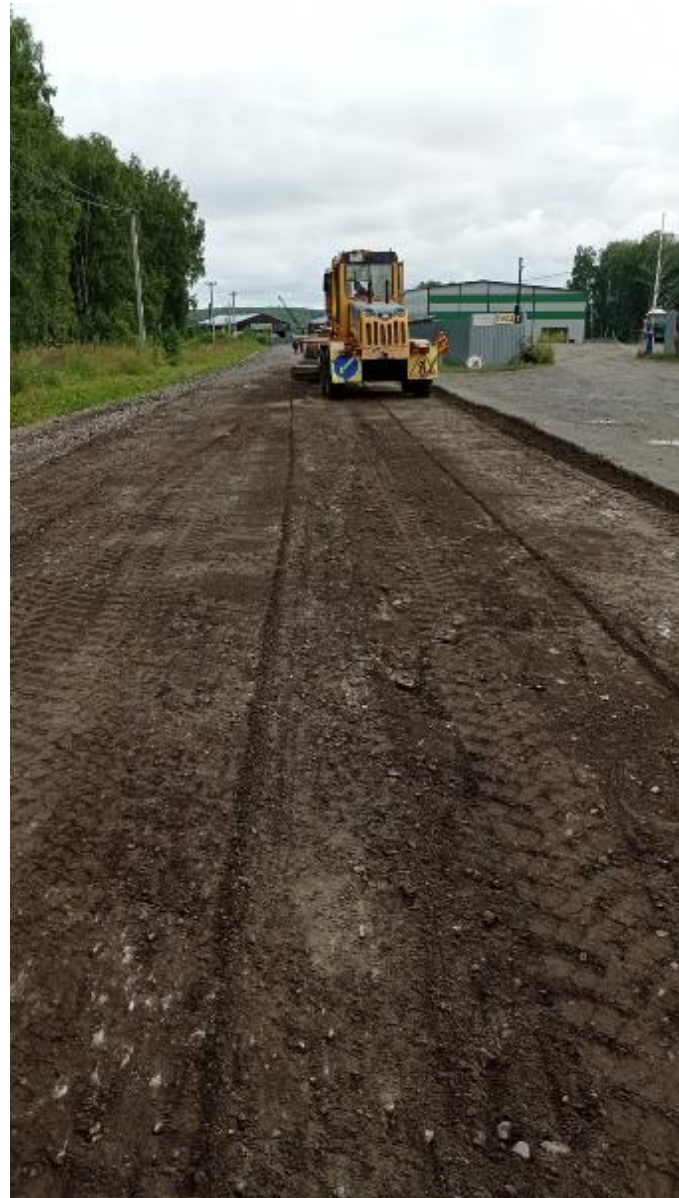
Исправление профиля без добавления нового материала
