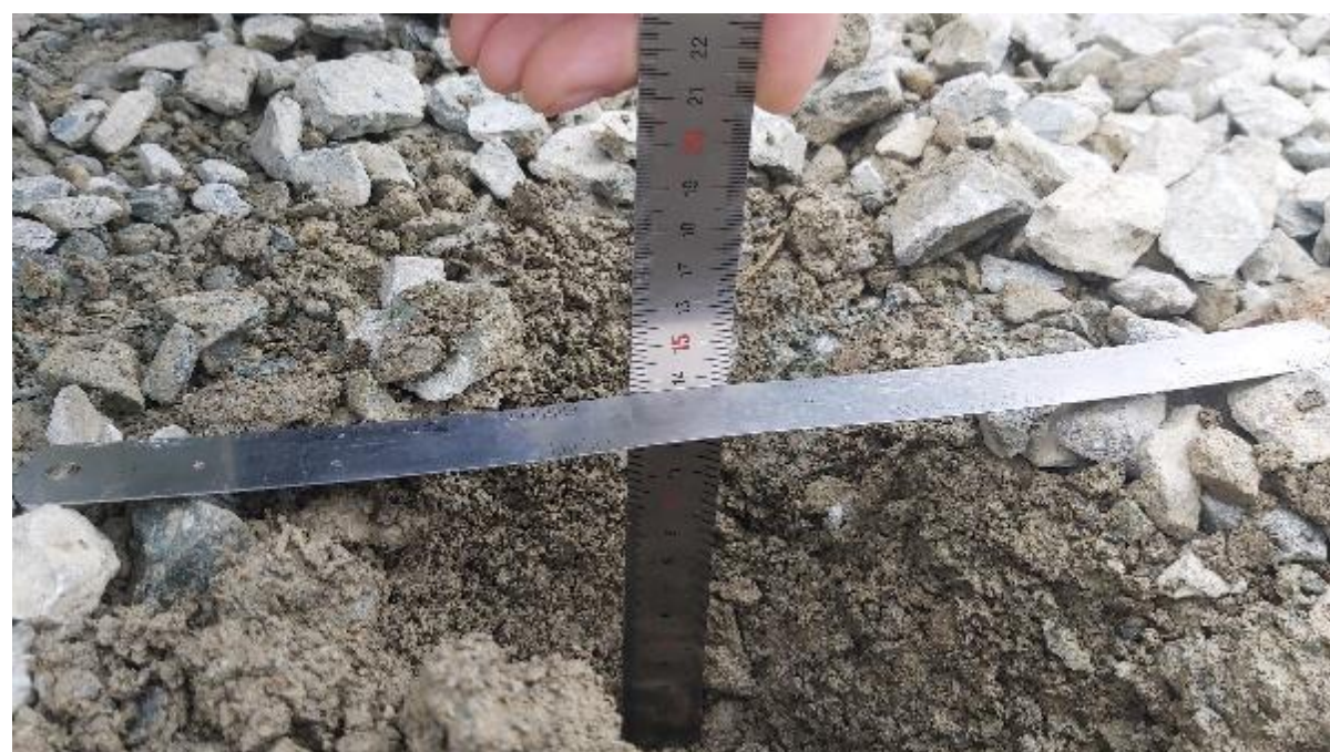
Устройство покрытия из ЩПС С1
