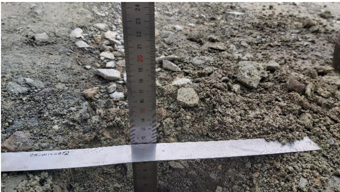
Устройство покрытия из ЩПС С1
