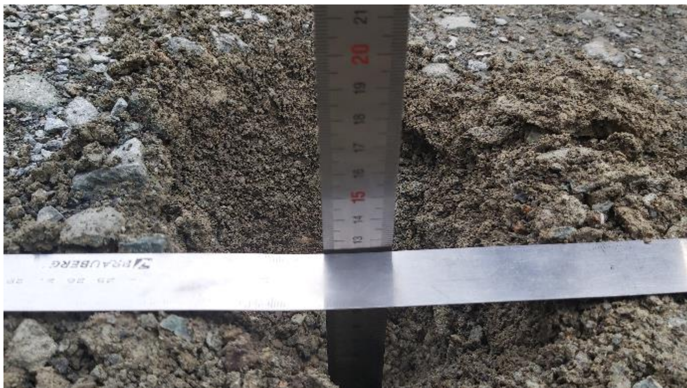
Устройство покрытия из ЩПС С1
