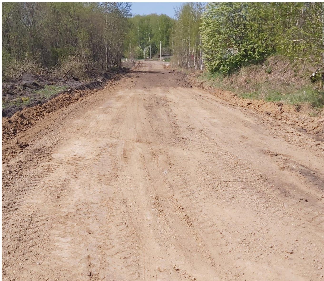
Устройство основания из глинистого грунта
