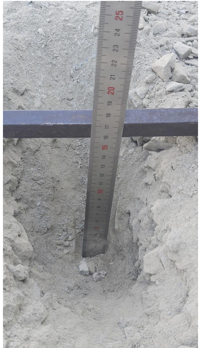
Устройство покрытия из ЩПС С1
