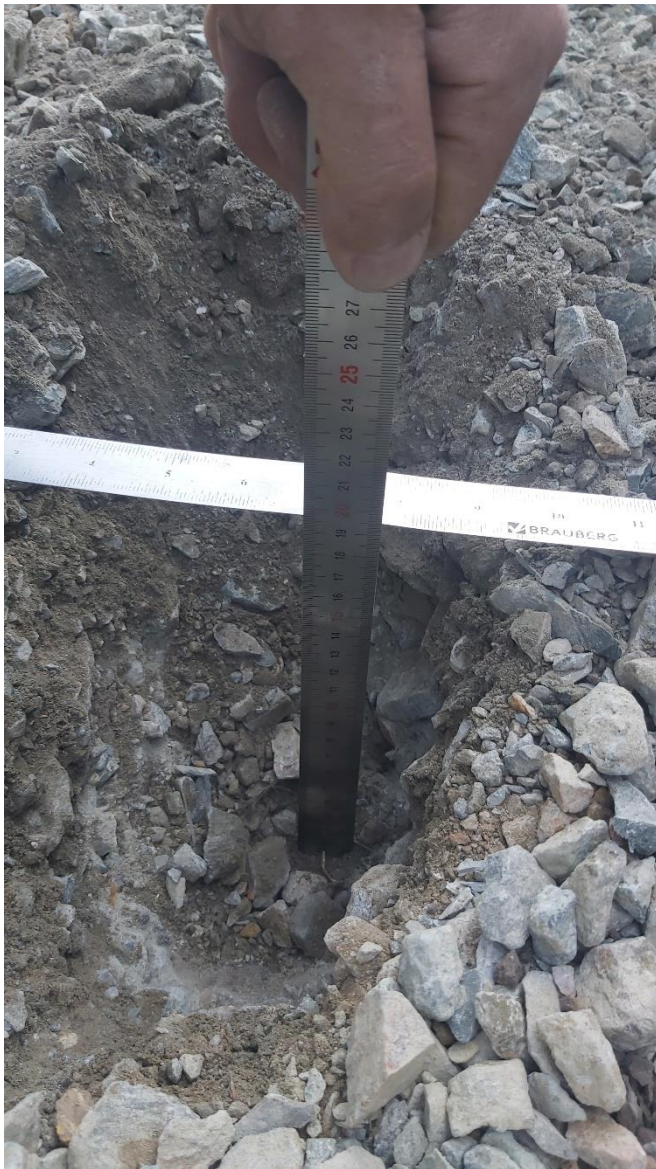
Устройство покрытия из ЩПС С1
