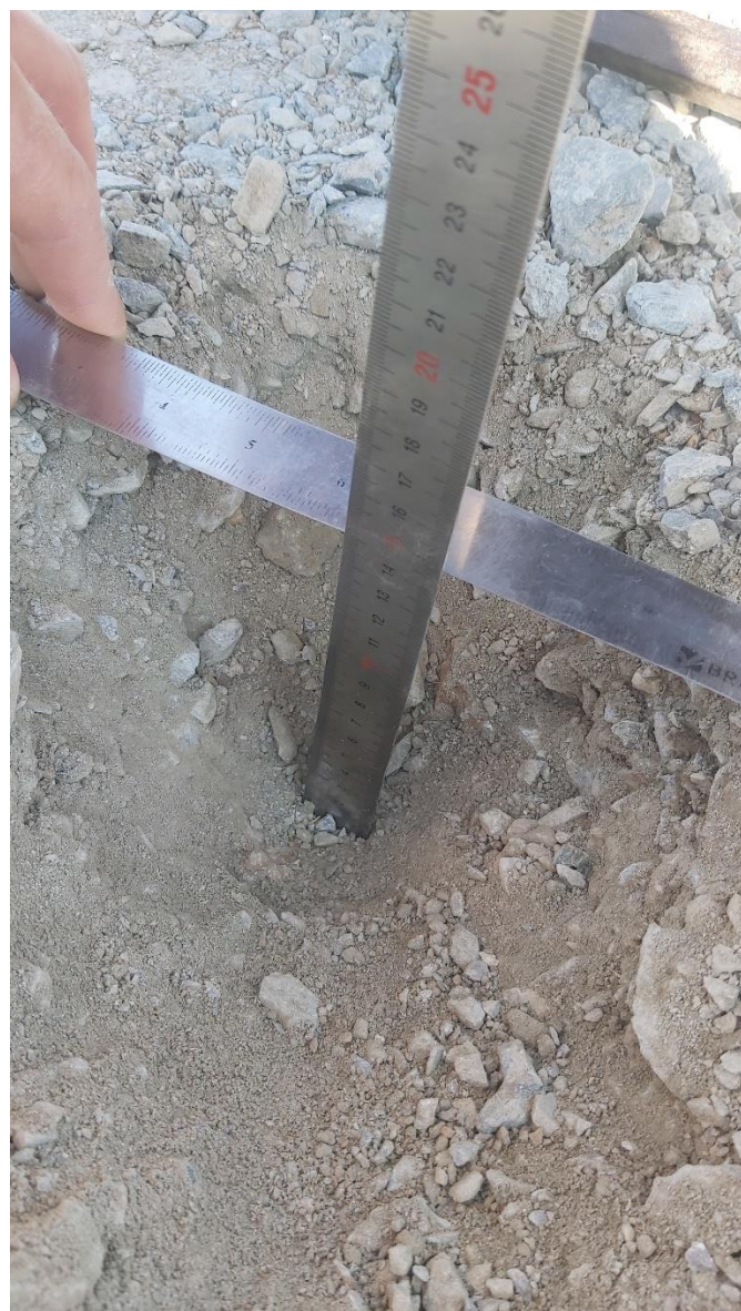
Устройство покрытия из ЩПС С1
